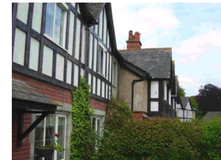
Fig 20. Nos 36a-48b High St
