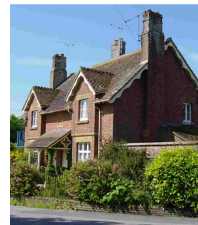
Fig 18. Nos 18 & 20 Mill St
