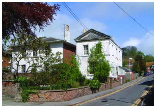
Fig. 48 Nos. 24 & 26 West Allington
