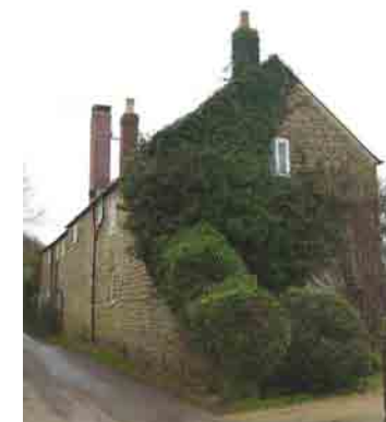
Fig 45. Nos 1 & 2 Mill Lane
