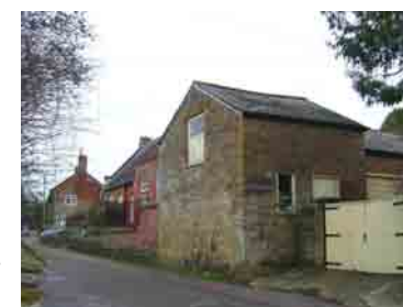
Fig 25. Old Vicarage stables
