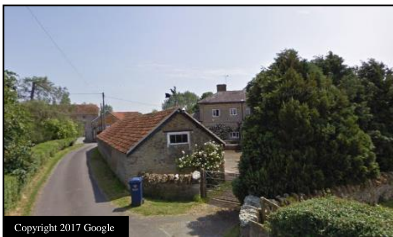
Fig. 34 Purns Mill Barn
